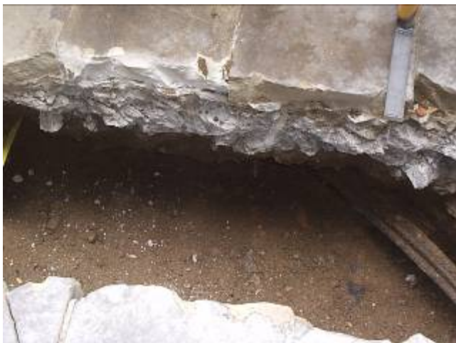
Foto 3. Detall del final de la rasa excavada.
